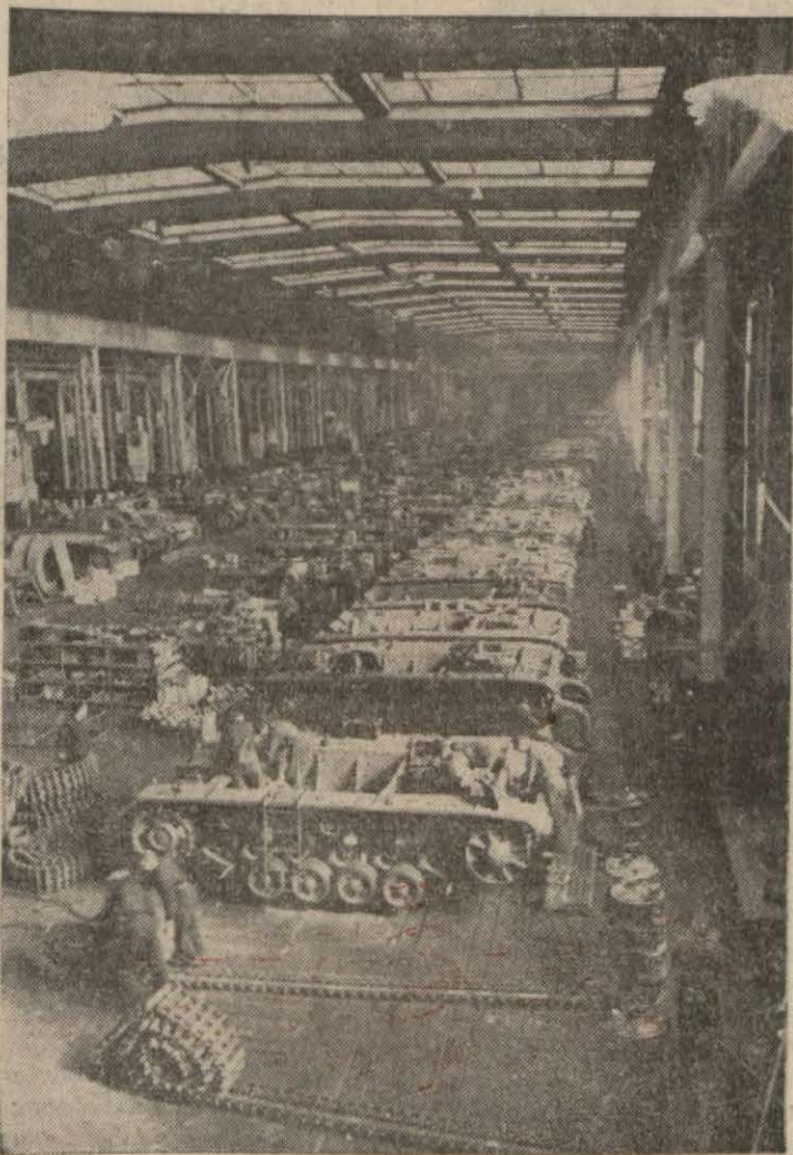
Şark cephesine yetiştirilmek üzere Almanyada tank imalatına baş verilmiş- tir. Burada bir montaj atölyesi görülmüş.
